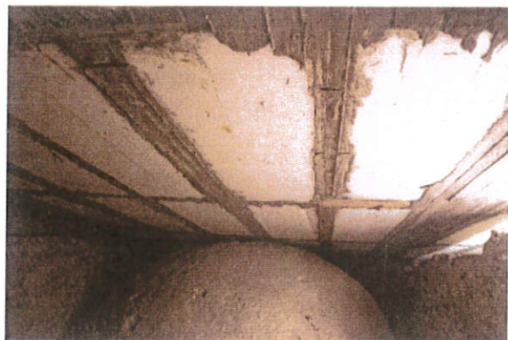
εικ. 4-10: Δοκιδωτή πλάκα πάνω από τους θολίσκους των γωνιαίων διαμερισμάτων
