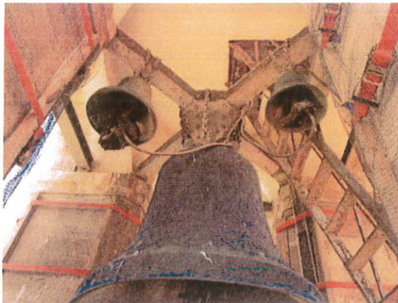
εικ. 4-13: Μεταλλικό διάφραγμα από όπου αναρτώνται οι κωδώνες
