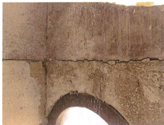
εικ. 6-30: Οριζόντιο επίπεδο αστοχίας κάτω από το ρολόι του 5 ου επιπέδου και πάνω από τα δίλοβα παράθυρα, εσωτερικά.
