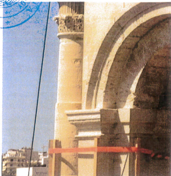
εικ. 6-25: Επίπεδο ολίσθησης στο επίπεδο της έδρασης των τόξων του 4 ου επιπέδου. Β. Κωδωνοστάσιο.
