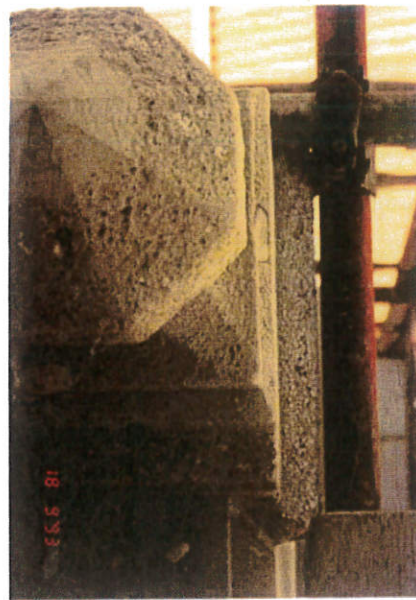
εικ. 5-26: Ν. Κωδωνοστάσιο, Β' Διάζωμα, ΒΔ Γωνία, Διάβρωση διακοσμητικού στοιχείου στηθαίου το οποίο είχε ανακατασκευαστεί στην προηγούμενη φάση επισκευών, 1993, Αρχείο Βασιλάκη
