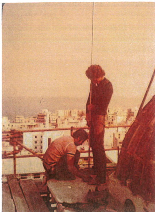
εικ. 5-13: Τοποθέτηση ράβδου από ανοξείδωτο χάλυβα. Β. Κωδωνοστάσιο Δεκαετία 1980. Αρχείο Βασιλάκη
