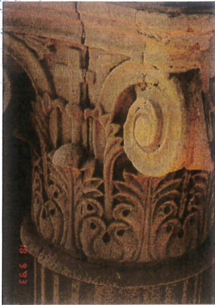
εικ. 5-25: Ν. Κωδωνοστάσιο, Β' Διάζωμα, Ρωγμές στο κιονόκρανο του Β.Α. Κίονα. 1993, Αρχείο Βασιλάκη
