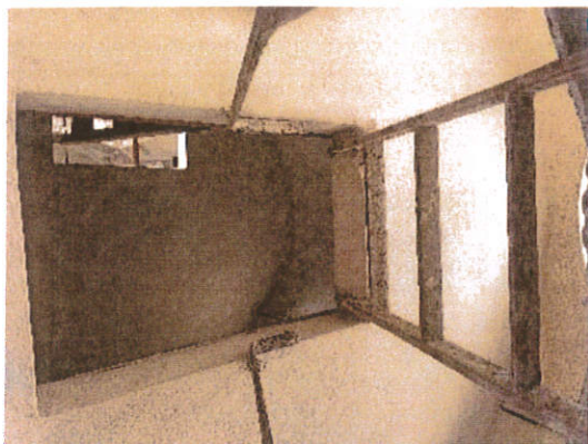
εικ. 3-38: Μεταλλική κλίμακα ανόδου στον ενδιάμεσο χώρο μεταξύ 4 ου και 5 ου επιπέδου.
