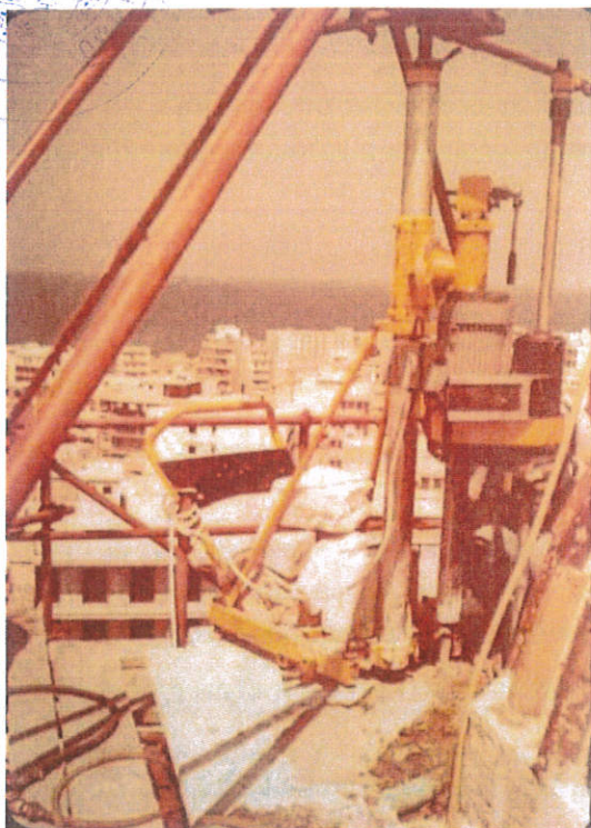
εικ. 5-12: Το διατρητικό μηχάνημα στο επίπεδο έδρασης του τρούλου του Β. κωδωνοστασίου. Δεκαετία 1980. Αρχείο Βασιλάκη
