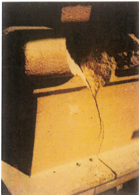
εικ. 5-27: Ν. Κωδωνοστάσιο, ΝΔ Γωνία, Βλάβη στο Γείσο του Β' Διαζώματος, 1993, Αρχείο Βασιλάκη
