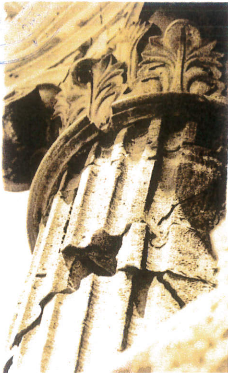
εικ. 5-8: Ρωγμές σε κίονα του Β' Διαζώματος Κωδωνοστασίου, 1979. Αρχείο Βασιλάκη
