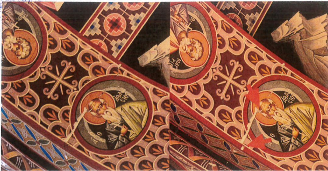
εικ. 6-55 : Μικρή διάνοιξη υφιστάμενης ρωγμής στο εσωράχιο του δυτικού τόξου
