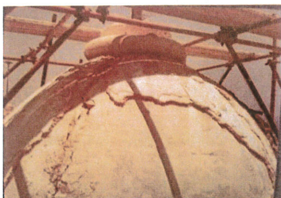
εικ. 5-14: Ο θόλος κωδωνοστασίου μετά την αφαίρεση της επικεράμωσης. Δεκαετία 1980. Αρχείο Βασιλάκη
