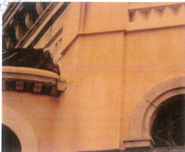
εικ. 6-5: οριζόντιες διατμητικές ρωγμές στους πεσούς του οκταγώνου
