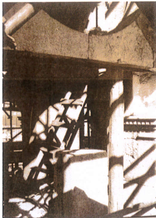
εικ. 5-7: Καθαίρεση δίομβου ανοίγματος κάτω από το ρολόι και αποκαλυψη σιδερένιας λάμιας 50x20. Νότιο Κωδωνοστάσιο. Νοέμβριος, 1979. Αρχείο Βασιλάκη
