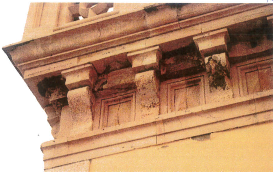
εικ. 7-7 : Οραυμένοι λίθοι γείσου 4 ου επιπέδου Β. Κωδωνοστασίου που προτείνεται να αντικατασταθούν.
