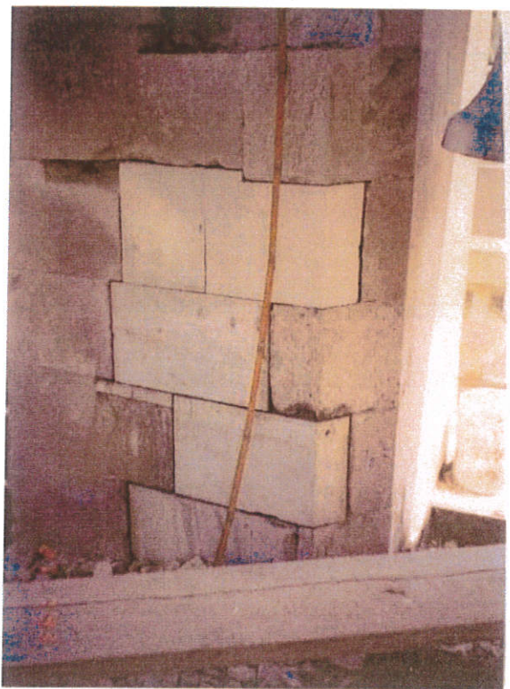
εικ. 5-35: Β. Κωδωνοστάσιο, Α' Διαζώμα, λίθοι στον πεσό που έχουν αντικατασταθεί, 1993, Αρχείο Βασιλάκη
