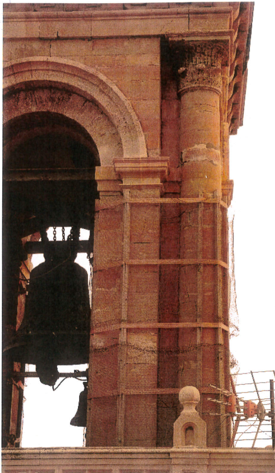
εικ. 7-6 : ΝΑ πεσσός Β. Κωδωνοστασίου, 4 ου επιπέδου. Προτείνεται η ανασκατάτασκηή των λίθων των πεσσών του επιπέδου αυτού από την εξωτερική πλευρά, καθώς όπως φαίνεται και στην εικόνα είναι σε μεγάλο βαθμό θραυσμένοι.
