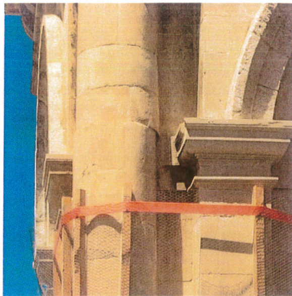
εικ. 6-26: Επίπεδο ολίσθησης στο επίπεδο της έδρασης των τόξων του 4 ου επιπέδου. Ν. Κωδωνοστάσιο.
