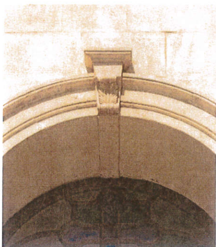
εικ. 3-13: Κλειδί τοξωτών ανοιγμάτων κεντρικής εισόδου
