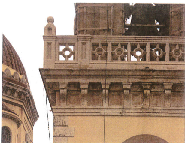
εικ. 3-32: Γείσο και στηθαίο στο άνω μέρος του τρίτου επιπέδου.
