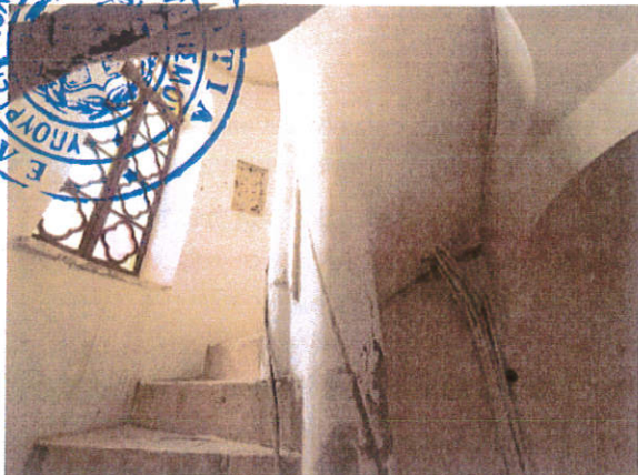
εικ. 4-12: Ελικοειδής κλίμακα β. κωδωνοστασίου. Φαίνεται η μετατόπιση του κέντρου της και τα τυφλά αψιδώματα που την παραλαμβάνουν.
