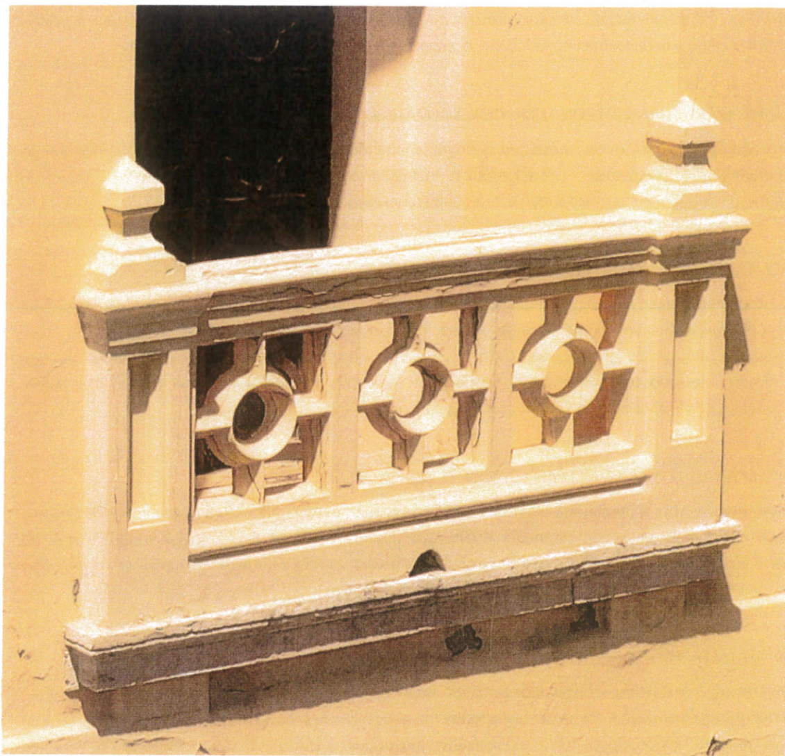
ΕΙΚ. 7-9 : Στηθαίο 3 ου επιπέδου βόρειου κωδωνοστασίου για το οποίο προτείνεται αντικατάσταση με ινοπλισμένο σκυρόδεμα.
