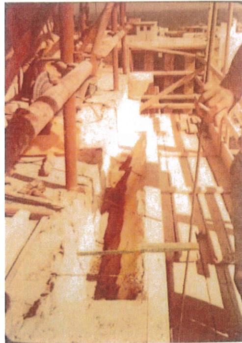
εικ. 5-23: Κατασκευή περιμετρικού εξώστη Α' Διαζώματος από σκυρόδεμα. Δεκαετία 1980. Αρχείο Βασιλάκη
