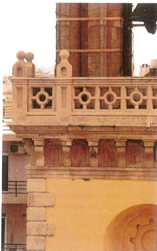
εικ. 7-8 : Οραυμένοι λίθοι γείσου 4 ου επιπέδου Β. Κωδωνοστασίου που προτείνεται να αντικατασταθούν.
