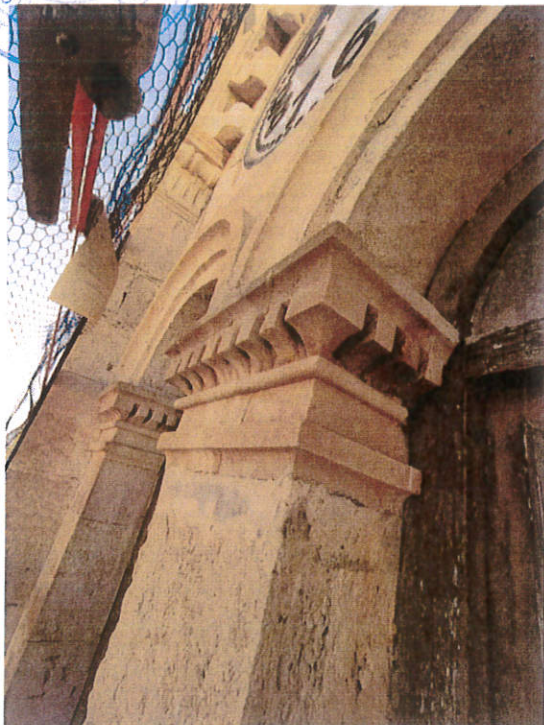
εικ. 3-42: Επίκρανα πεσσών διλοβου ανοίγματος 5 ου επιπέδου.
