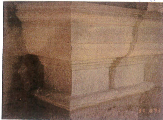
εικ. 5-34: Το επίκρανο πεσσού του Α' Διαζώματος του Β. Κωδωνοστασίου το οποίο έχει ξαναλαξευτεί σε δύο μέρη και επανατοποθετηθεί στη θέση του, 1993, Αρχείο Βασιλάκη
