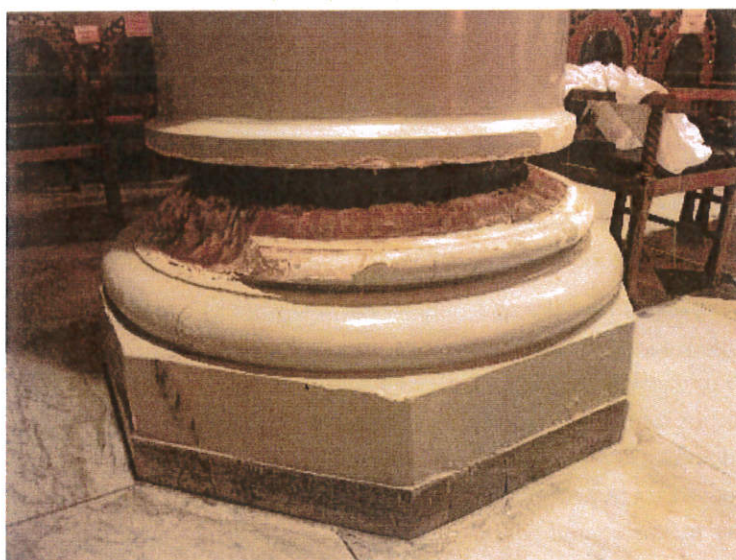
εικ. 4-8: Μεταλλική περίδεση στην έδραση κίονα
