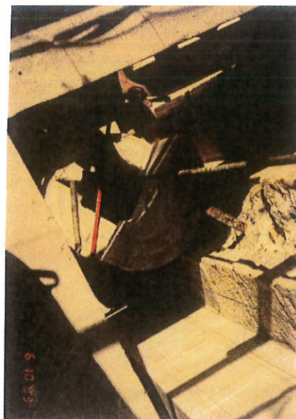
εικ. 5-30: Ν. Κωδωνοστάσιο, Α' Διάζωμα, Ν.Α. Κίονας υπό ανακατασκευή. Τοποθετούνται λίθινοι σπόνδυλοι σε δύο μέρη, κούφιοι στο εσωτερικό στη θέση όπου προϋπάρχει η μεταλλική ράβδος. Δεκαετία 1990. Αρχείο Βασιλάκη
