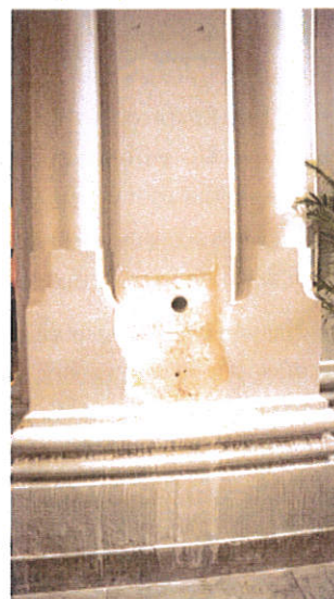
εικ. 4-9: Διερευνητική τομή στον Ν.Δ πεσσό όπου διακρίνεται η επιμελημένη τοιχοποιία από συμπαγή λιθοσώματα
