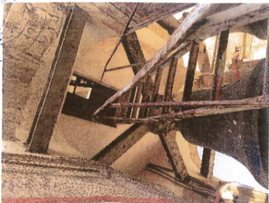
εικ. 3-36: Μεταλλικοί δοκοί από τους οποίους αναρτώνται οι κώδωνες.
