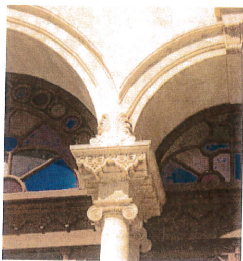
εικ. 3-11: Λεπτομέρεια επιθήματος διπλού ιωνικού κίονα εισόδου
