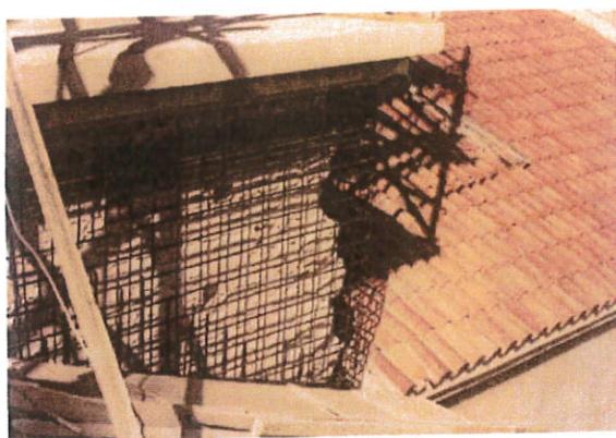
εικ. 5-39: Ανακατασκευή μανδύα στη βάση του τυμπάνου του τρούλου, 1992, Αρχείο Βασιλάκη
