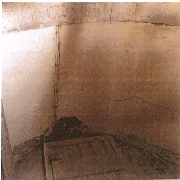
εικ. 6-28: Οριζόντιες στρεπτικές ρωγμές στο εσωτερικό μεταξύ 4 ου και 5 ου επιπέδου. Β. Κωδωνοστάσιο.
