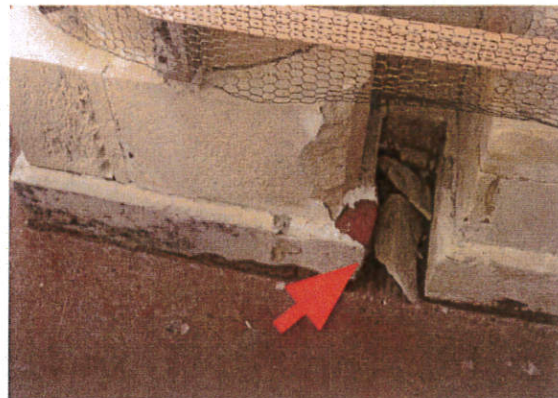
εικ. 6-57 : Θραύσματα που αποσπάστηκαν από διάφορους λίθους στο βόρειο κωδωνοστάσιο.
